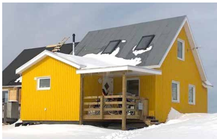
Indgangen er flyttet ud i en ny vinkel med overdækket terrasse. Der er kommet Velux vinduer i overetagen.
