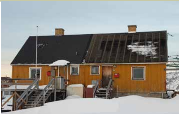
Soklen genbruges og forlænges, samt gulvet isoleres
