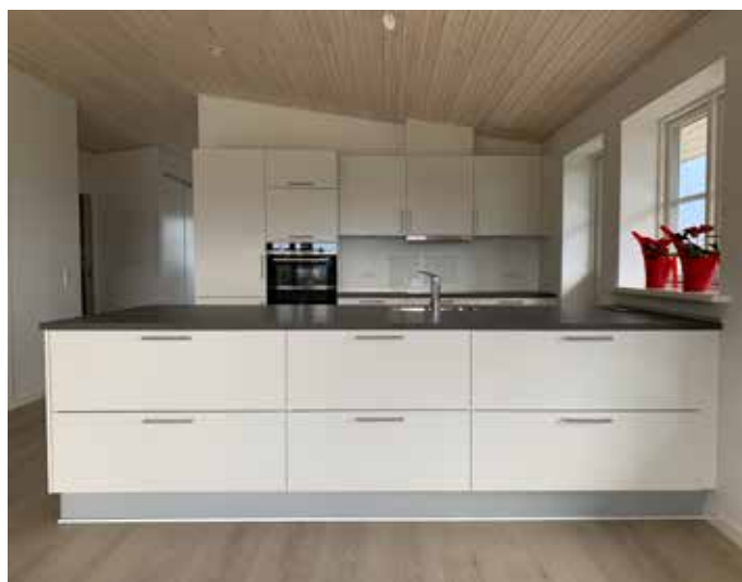
Foto: Saksespær med loft mod kip, profilbræddelofter, højtryks-laminatgulv, HTH standard køkken
